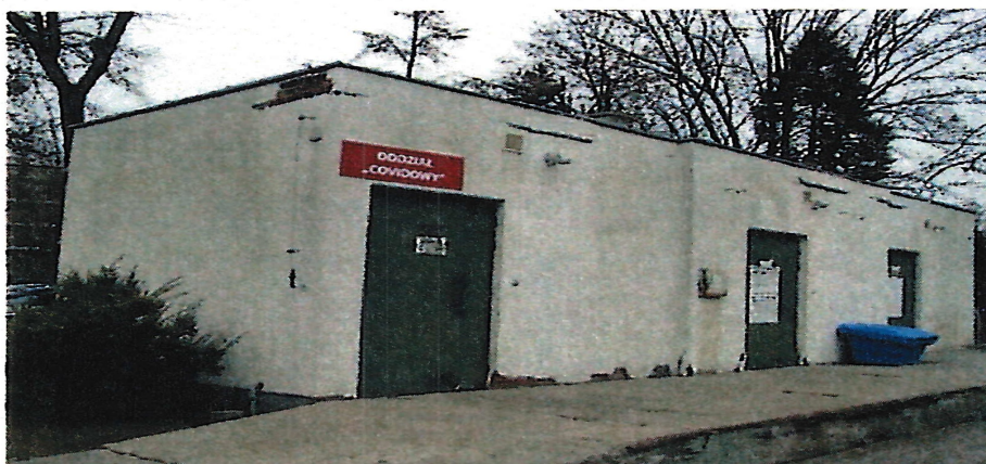
18. Foto budynku nr 1
