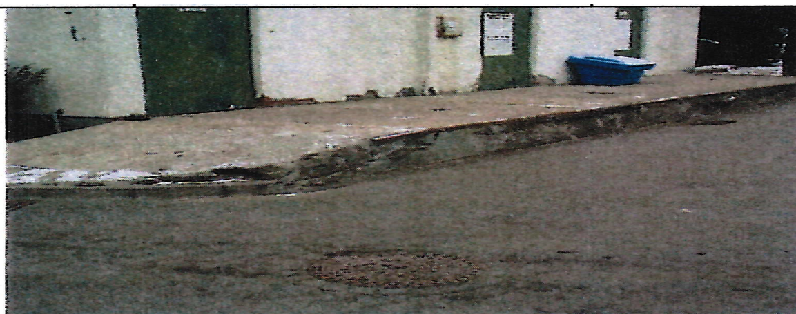
19. Foto budynku nr 2
